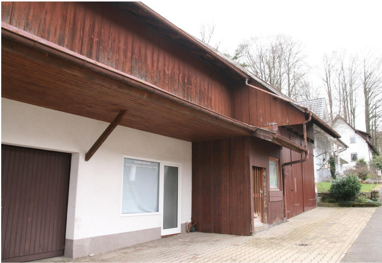
Abb. 4: Westfassade des Ökonomiegebäudes
