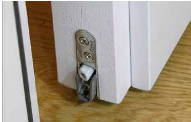
Beispiel Bodendichtung Tür
